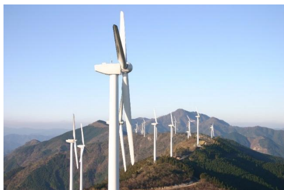
津野町と仁淀川町の尾根筋にある風車群 20 基 (葉山風力発電所)
